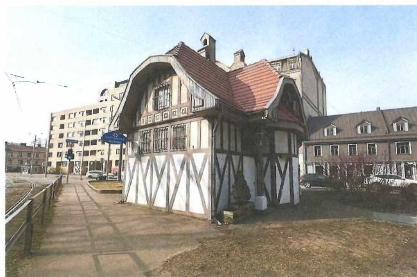
6.attēls. Būves nesošā sienas veidotas koka karkasa konstrukcijā ar ķieģeļu mūra aizpildījumu.
