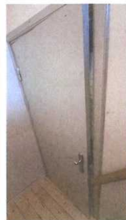
30. attēls. Galvenās ieejas durvis un vitrīna. 31., 32. attēls. Blīvas preskartona iekšdurvis.
