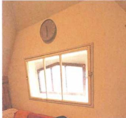
29. attēls. Logu bloks ar papildus vērti.
