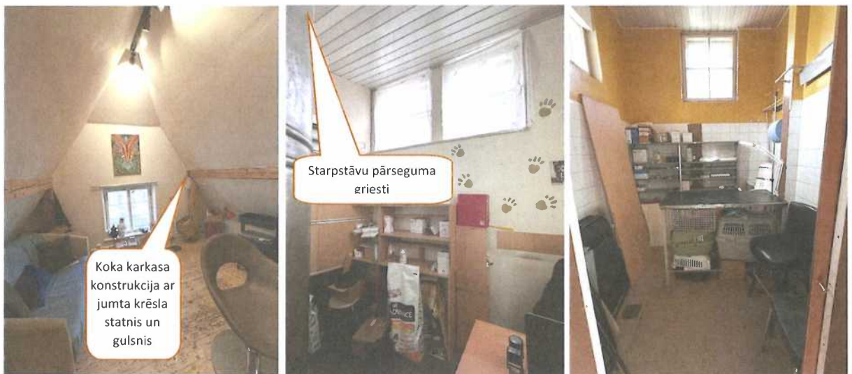
16., 17., 18.attēls. Starpstāvu pārseguma un jumta (savietota konstrukcija) apdare: grīdas un griesti.
