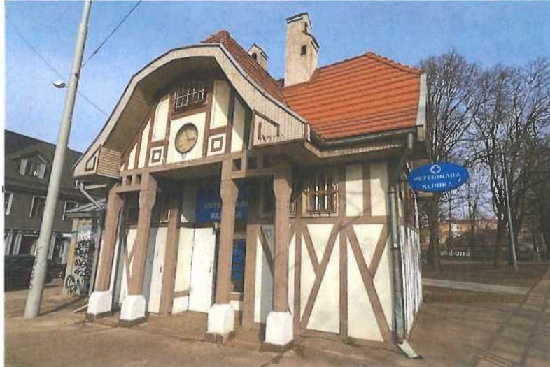
7.attēls. Būves galvenā fasāde. Ieejas mezgla veido 4 koka koka kolonnas.
