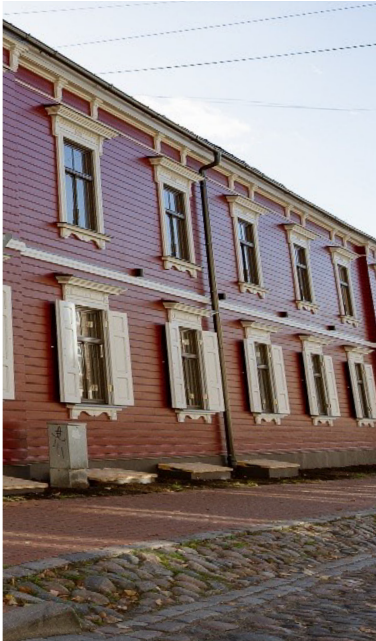
Fasādes apdares atjaunošana Mūrnieku ielā 14 kultūrvēsturiskā būvmantojuma saglabāšanas ietvaros
